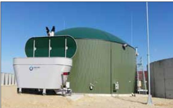
*Angesichts des Gülleanteils reicht ein kleiner, 35 Kubikmeter fassender Dosierer zum Eintrag der Feststoffe, wie Maissilage, aus.*
